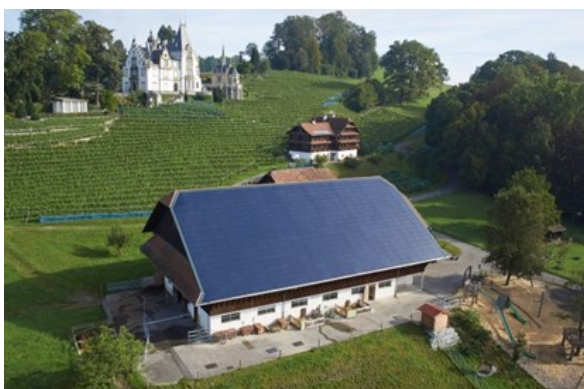
Schlossgut Meggenhorn (ISOS-Inventar mit Erhaltungsziel A), Meggen LU. Scheune mit 100 kW / 580 m 2 Photovoltaikmodulen, vollflächig integriert.
