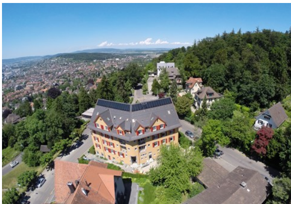
Solarthermieanlage (unverglaste Kollektoren) auf dem denkmalgeschützten Justinushaus in Zürich (Baujahr 1907). Kompakte, zusammenhängende Anlage unterhalb des Firsts zur Regeneration der Erdsonden.
