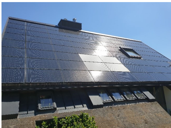
Abbildung 9: Bemusterung mit vier blendfreien Modulen
