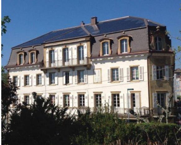
Hôtel des Associations, Neuchâtel, im Quartier du Tertre, ISOS-Inventar mit Erhaltungsziel A. Dachintegrierte Photovoltaikanlage mit 28 kW.
