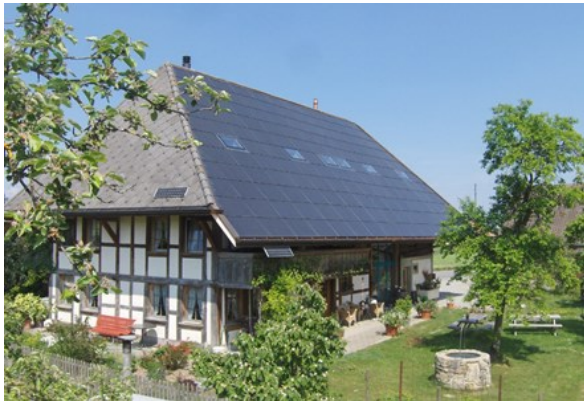
Vollflächig integrierte Photovoltaikanlage auf einem Bauernhaus in Schüpfenried (BE). Damit die Modulfläche das gesamte Dach bedecken kann, wurden in den Randbereichen schräge Blindmodule verwendet.
