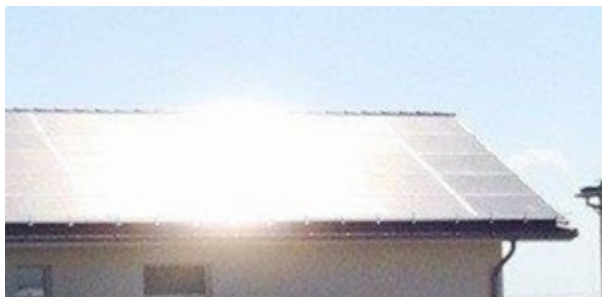
Abbildung 7: Blendwirkung eines Schrägdachs. Deutlich sichtbar ist die Bündelaufweitung, dadurch erkennbar, dass anstelle des direkten Abbilds der Sonne eine flächige Lichterscheinung sichtbar ist.
