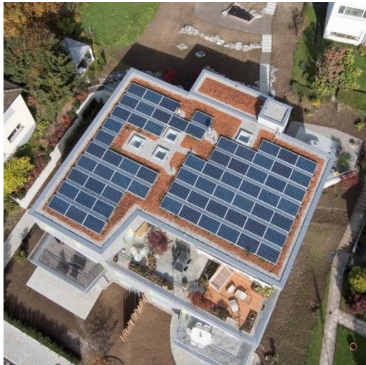
© BE Netz AG, Flachdachanlage mit Oblichtern in Stäfa
