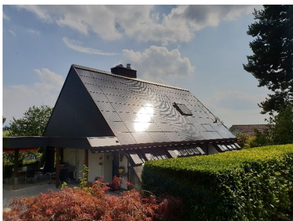
Abbildung 8: Dachfläche vor der Sanierung
