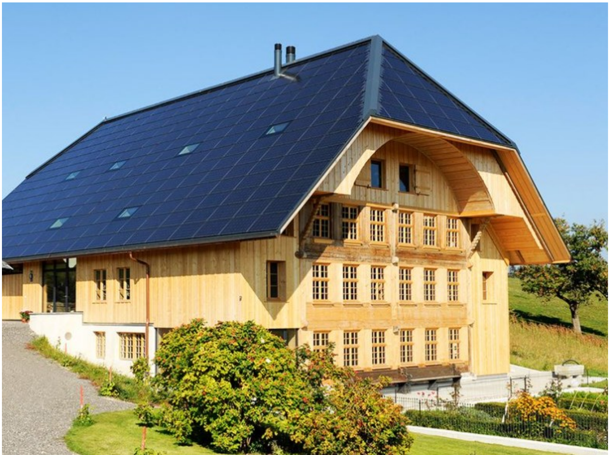
© clevergie ag, historisches Plusenergiehaus mit vollintegrierter PV-Anlage im Emmental sowie PV-Anlage auf dem Gehrschild, das ist die abgewalmte Giebelspitze bzw. das Bedachungsdreieck über der Giebelfront.
