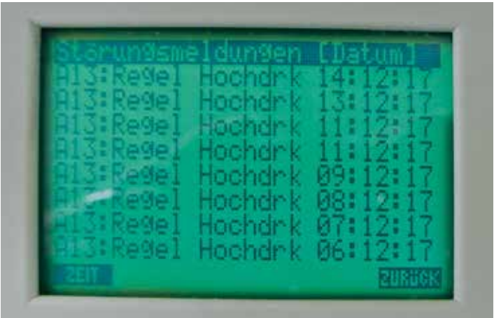
Illustration 6.5: Message d'erreur de la pompe à chaleur eau-eau. (Photo: Böhler, MTU GmbH)
