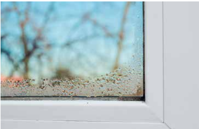
Illustration 2.7: La condensation sur les bords du vitrage est un signal d'alerte pour une humidité intérieure trop élevée. (Photo: Christoph Gross/stock.adobe.com)
