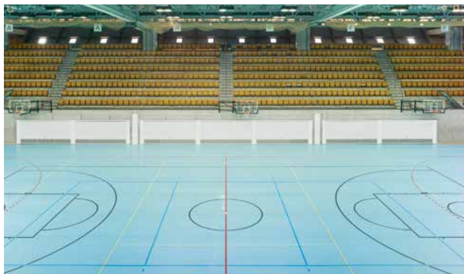
Illustration 6.15: L'éclairage existant de la salle a été partiellement remplacé par des projecteurs LED. (Photo: Ville de Berne)
