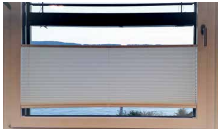
Illustration 2.11: Store à lamelles ex- térieur combiné avec une protection contre l'éblouisse- ment intérieur. (Photo: M. Hubbuch)
