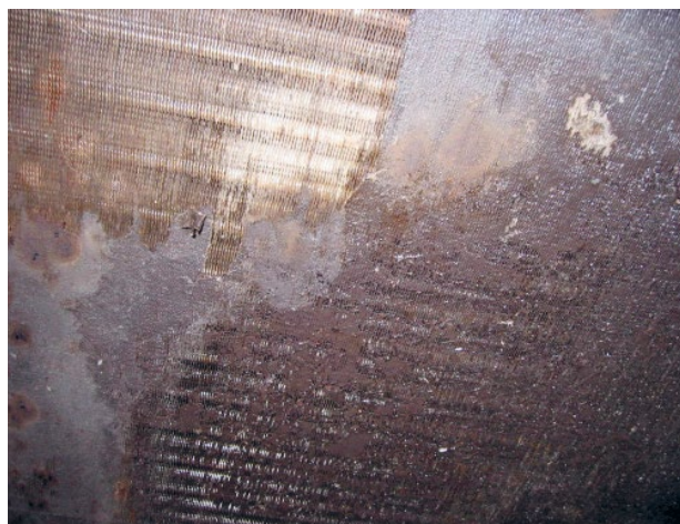
Foto: Sporco su un raffreddatore ad aria, le lamelle si stanno intasando.
